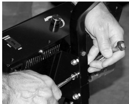
Montaje del gabinete de control
