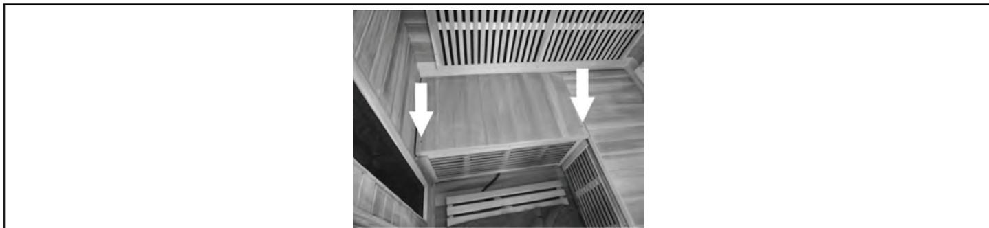
11. Soulevez le TOIT au-dessus du sauna, faites passer les fils du panneau de commande et des éléments chauffants dans les trous correspondants. Faites passer les fils du LECTEUR AM/FM/CD dans la fente au coin du TOIT. Fixez le TOIT du sauna à l'aide de VIS de 30 mm. Branchez le panneau de commande et les éléments chauffants.
